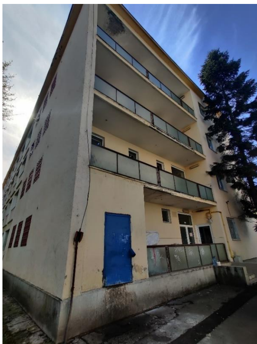
Foto 3. Cămin nr. 2 – fațada NV
