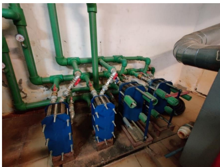
Foto 10. Centrala termică din Căminul nr. 1 – Schimbătoare de căldură pentru a.c.m.
