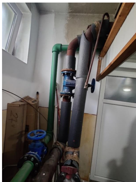
Foto 12 - 13. Cămin nr. 1 – conducte de la CT la canalul termic dintre Căminul nr. 1 și Căminul nr. 2, termoizolații degradate
