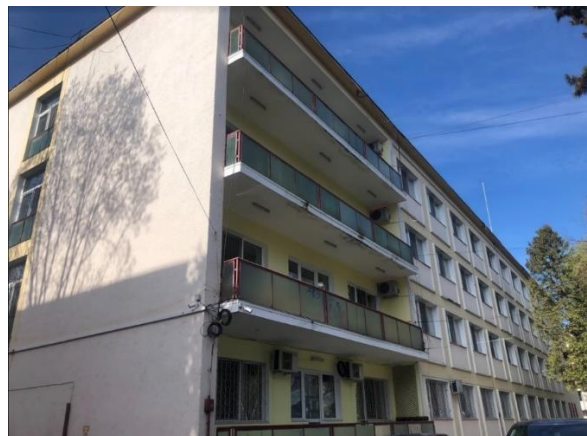
Foto 2. Cămin nr. 2 – fațada SE (stg.) și fațada NE (dr.)
