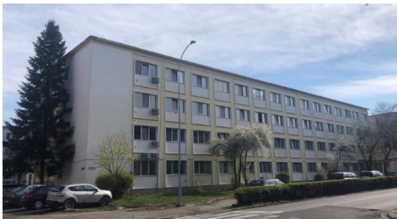
Foto 1. Cămin nr. 2 – fațada SV (fațada principală)
