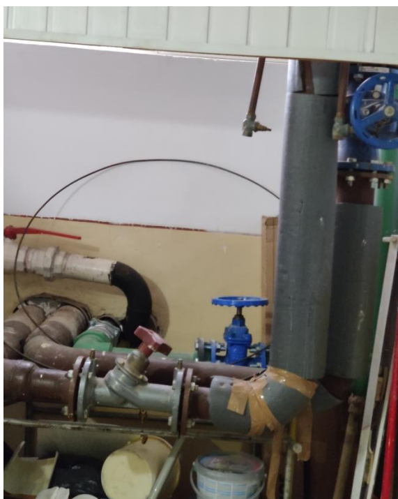
Foto 12 - 13. Cămin nr. 1 – conducte de la CT la canalul termic dintre Căminul nr. 1 și Căminul nr. 2, termoizolații degradate
