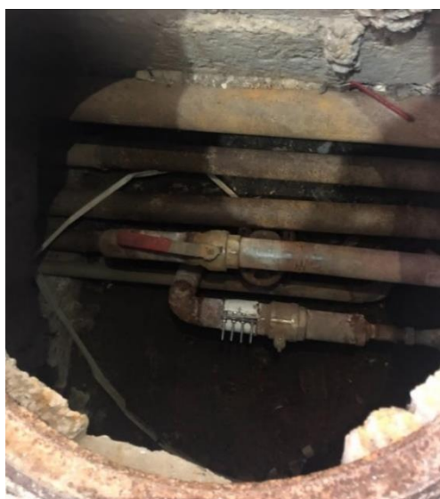
Foto 10. Conducte netermoizolate în subsolul tehnic
