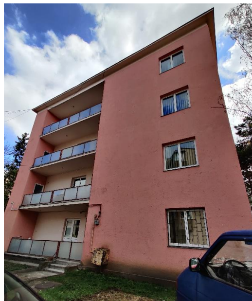
Foto 4. Cămin nr. 4 – fațada NV
