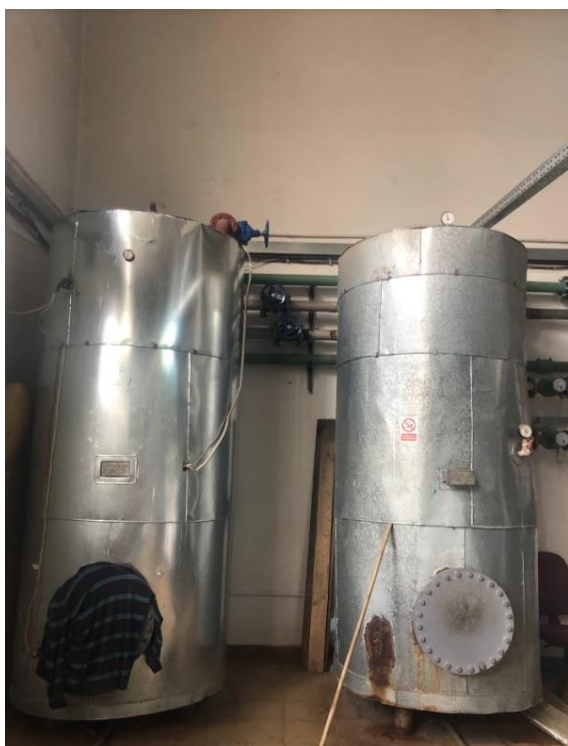
Centrala termică din Centrul de examinare – Foto 13. Acumulator a.c.m. (an fabricatie: 1964)
