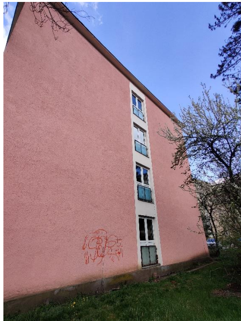
Foto 2. Cămin nr. 4 – fațada SE
