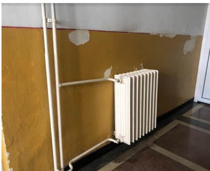
Foto 9. Cămin nr. 4 – Corp static din fontă fără elemente de reglaj
