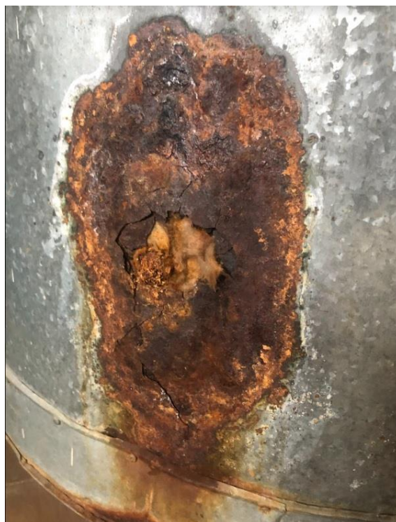
Centrala termică din Centrul de examinare – Foto 13. Acumulator a.c.m. (an fabricatie: 1964)
