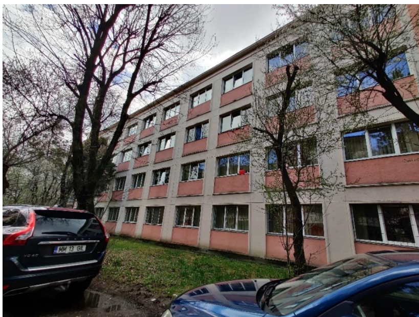
Foto 3. Cămin nr. 4 – fațada NE
