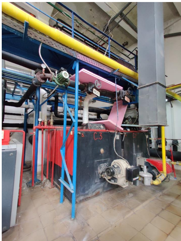
Centrala termică din Centrul de examinare – Foto 11. Cazane termice Romstal Confort 900 (încălzire)
