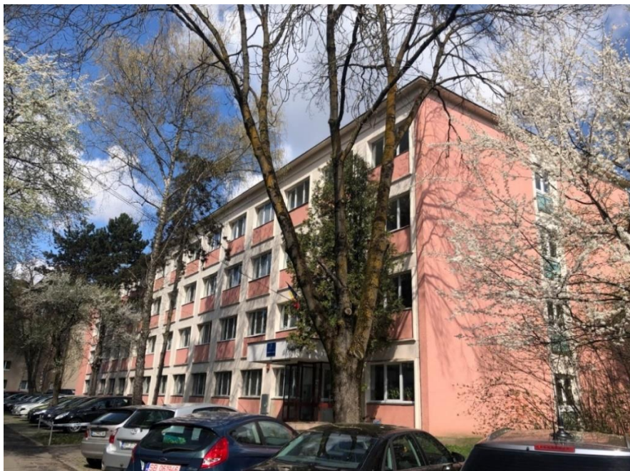
Foto 1. Cămin nr. 4 – fațada SV (fațada principală)
