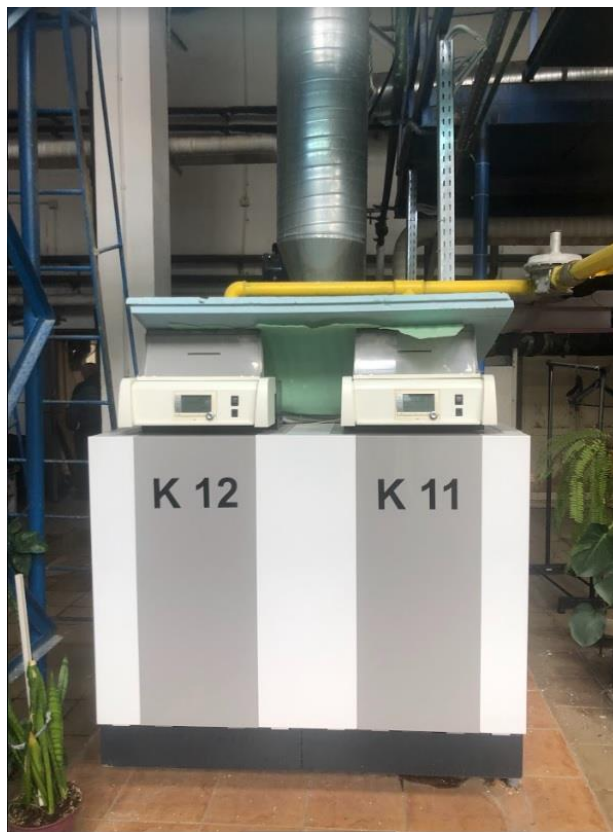
Centrala termică din Centrul de examinare – Foto 11. Cazane termice Romstal Confort 900 (încălzire)
