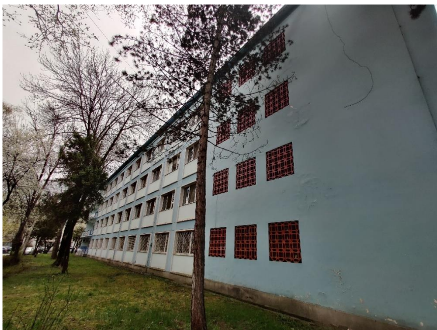
Foto 3. Cămin nr. 3 – fațada NE
