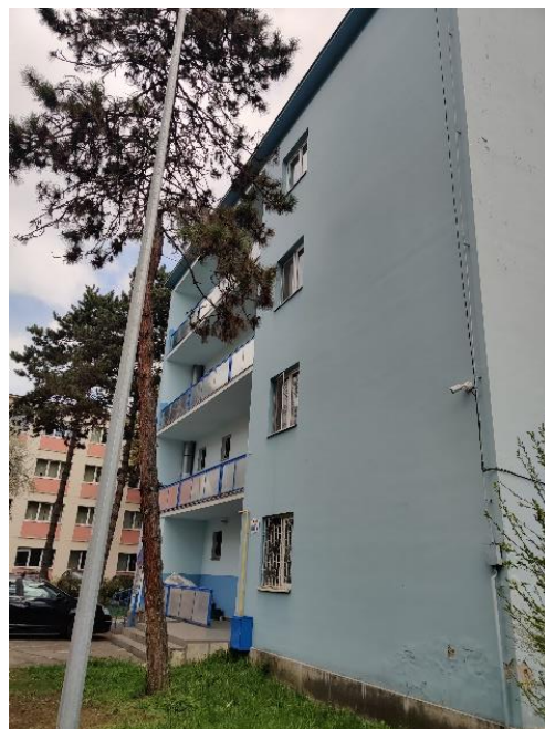
Foto 4. Cămin nr. 3 – fațada NV
