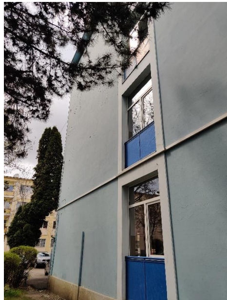
Foto 2. Cămin nr. 3 – fațada SE
