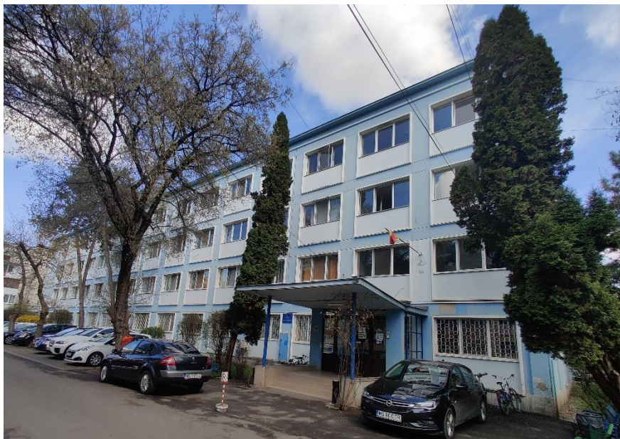
Foto 1. Cămin nr. 3 – fațada SV (fațada principală)
