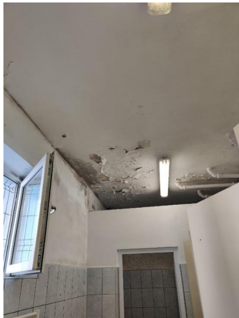
Foto 6. Infiltrații de apă planșeu/perete NE – grupuri sanitare
