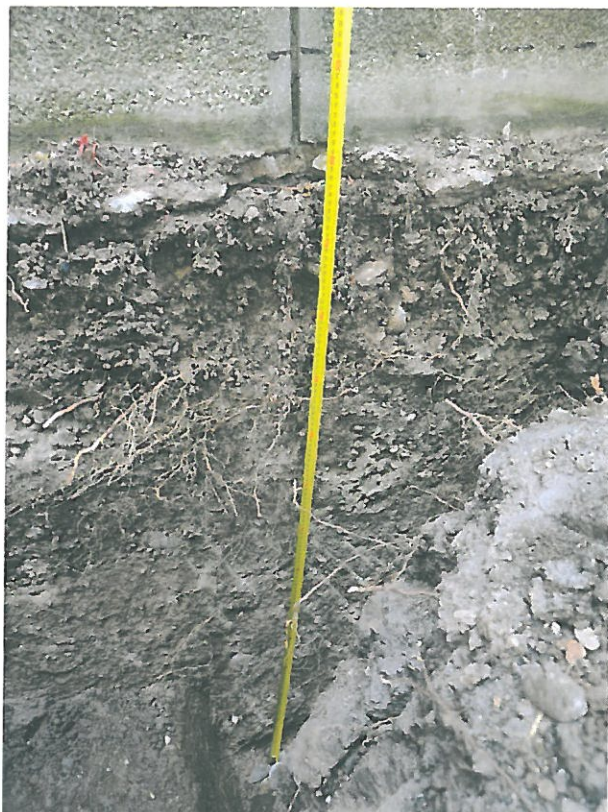
Sondaj la fundatiile existente ale constructiei.
