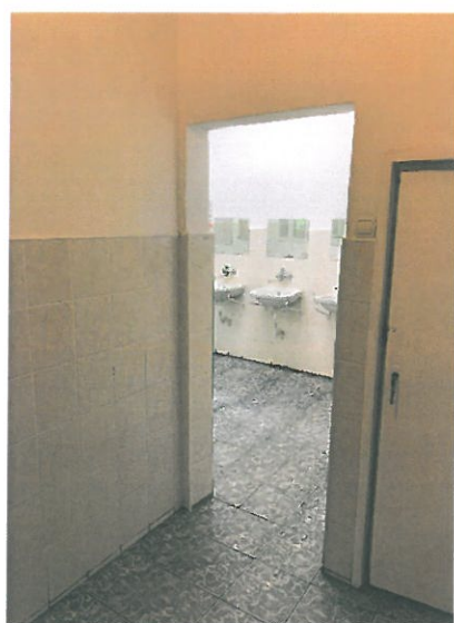
Zona grupuri sanitare si spalator, finisaje si placaje uzate moral, instalatii inechite
