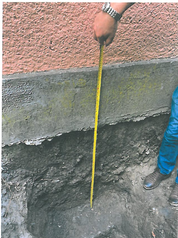
Sondaj la fundatiile existente ale constructiei pe una din fatadele laterale unde fundatia este evazata fata de soclu.
