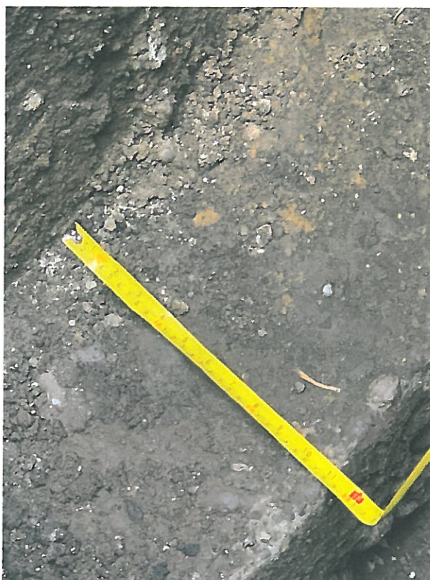
Sondaj la fundatiile existente ale constructiei pe una din fatadele laterale unde fundatia este evazata fata de soclu.
