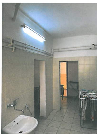
Zona grupuri sanitare si spalator, finisaje si placaje uzate moral, instalatii inechite
